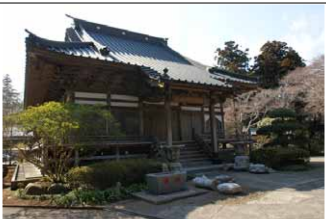
(26)善勝寺、311 の地震で燈籠倒れた
