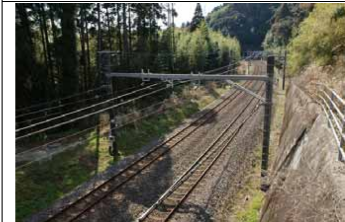
(23) ~ (24)JR 跨線橋の左手に土気トンネル
